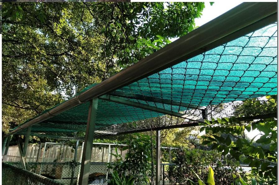
利用原本的鐵欄設置遮雨棚收集雨水
