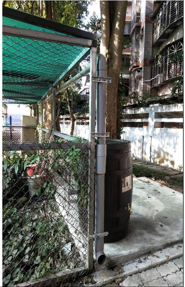
橡木桶造型雨水回收桶，約可收集 420 公升的雨水
